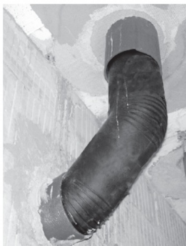
Esempi di attraversamento solaio con guaina disaccoppiante
