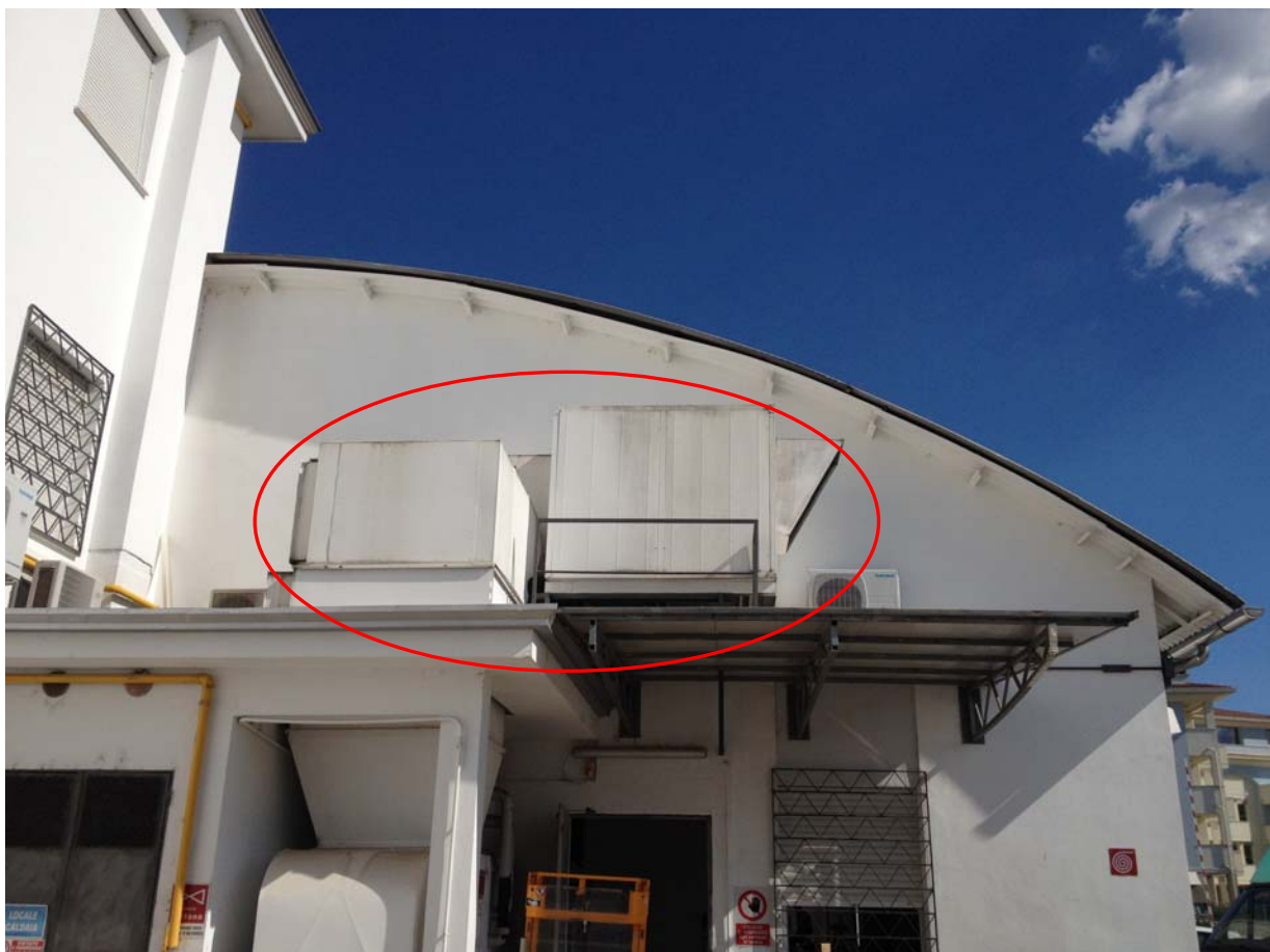
S2: N. 1 UTA esterna in angolo tra ufficio e laboratorio
