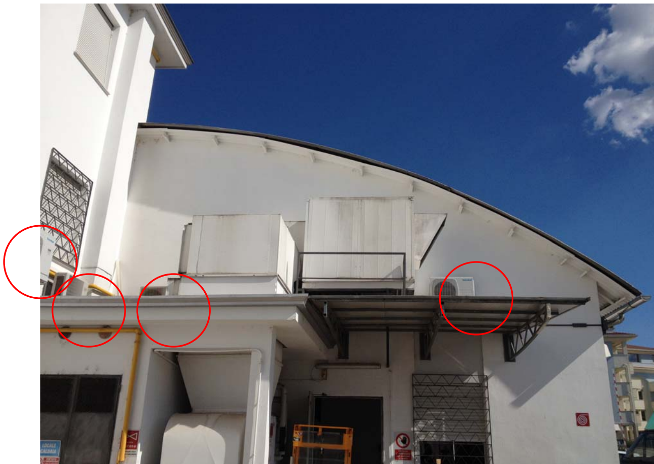
S2: N. 1 UTA esterna in angolo tra ufficio e laboratorio
