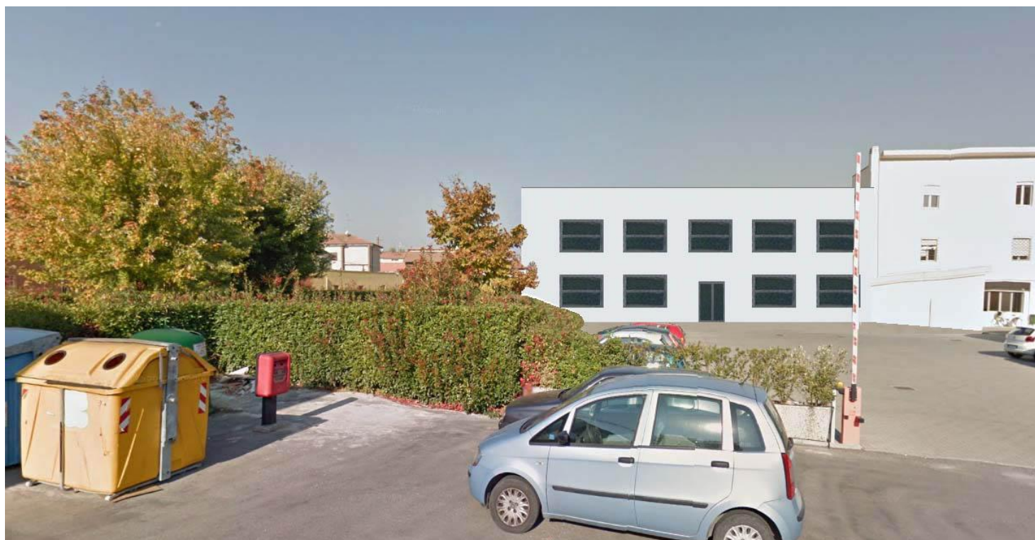
Dopo l'intervento di ristrutturazione e ampliamento - Piazzale Marconi
