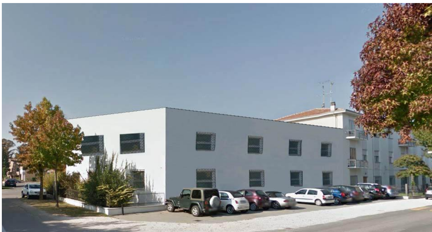
Dopo l'intervento di ristrutturazione e ampliamento - Via Agnini
