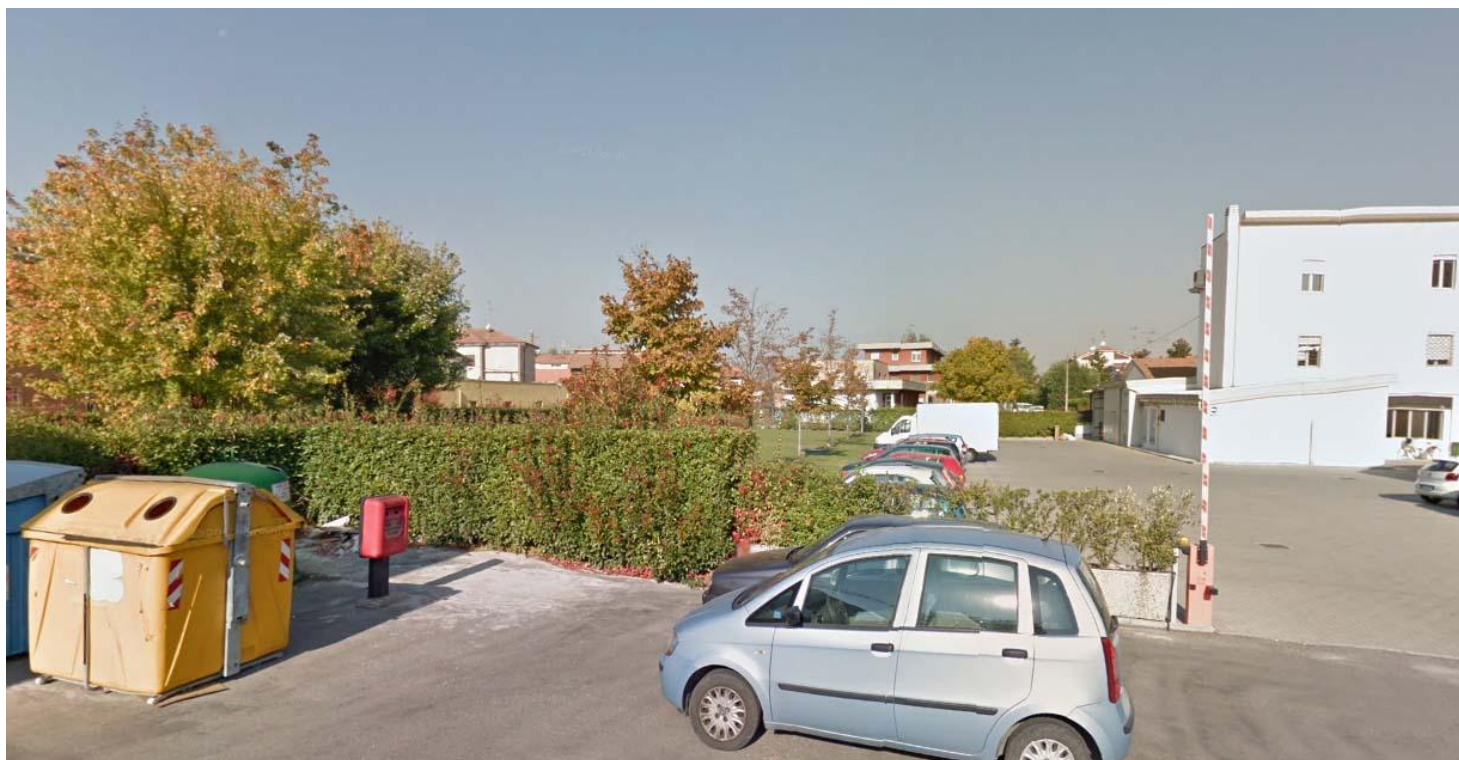
Prima dell'intervento di ristrutturazione e ampliamento - Piazzale Marconi
