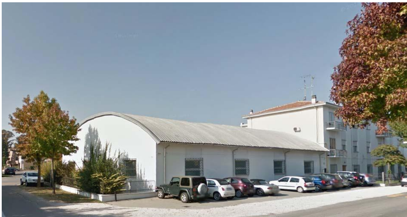
Prima dell'interventi di ristrutturazione e ampliamento - Via Agnini
